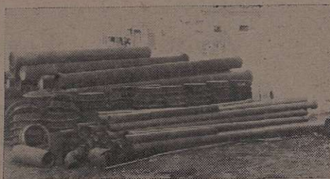
TUBOS DE FERRO FUNDIDO DE 75 M. M. PARA EXTENSÃO DA REDE DE ÁGUA, EM VILA GALVÃO
