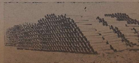
MANILHAS DE BARRO PARA ESGOTO SANITARIO, DEPOSITADAS NO JARDIM STA. FRANCISCA
