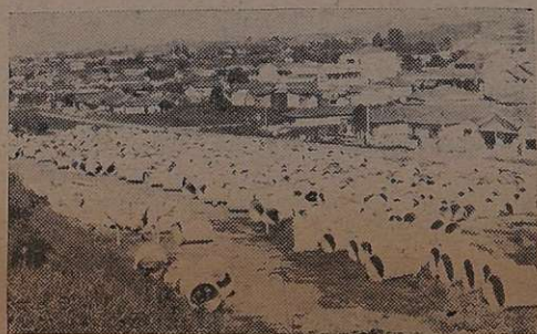
TUBOS DE CONCRETO PARA ESGOTO DEPOSITADOS EM V. GALVÃO
