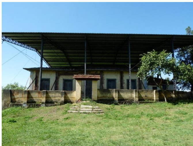
Foto AHCG “Araci Borges Dias Martins”, 2020. Casa da Candinha e sua cobertura metálica, quase duas décadas de espera.
