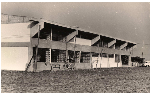
Foto 6: Construção da Escola de Primeiro Grau Francisco Antunes Filho. (Acervo: Arquivo Histórico da Cidade de Guarulhos – Data: 1974)
