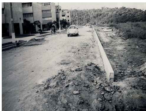
Foto 24 – Obras de pavimentação nos arredores do condomínio Rio de Janeiro (Acervo: Valdir Carleto – Data: s/d)
