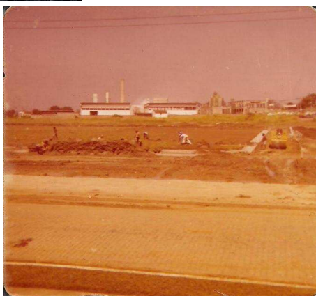
Foto 25 – Obras de construção do campo de futebol, atrás do condomínio Paraná (Acervo: Nelson Hernandez – Data: s/d)
